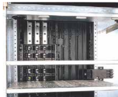
8E/4、8E/2装置小室，电缆和控制线连接（侧出线） Chamber for 8E/4 8E/2 connection of cable and control wire
